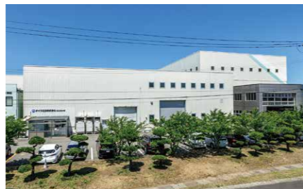
第2工場(自動機組立)
